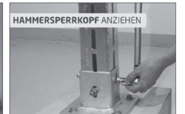
Schlüsselweite 19 mm. Bei XL 80 empfohlener Drehmoment 90 Nm . Bei XL100 empfohlener Drehmoment 120 Nm . Hammersperrkopf darf nach Demontage nicht wieder verwendet werden.
