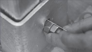
Hammersperrkopf nach vorne zur Führungsnase kippen. Anschließend durch Eindrehen der Mutter Hammersperrkopf handfest fixieren.
