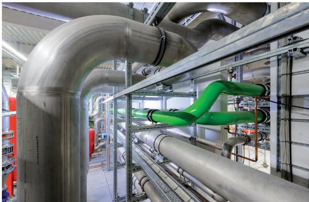
CENTUM® ist die ideale Lösung für den Rohrleitungs- und Anlagenbau. Schwere Lasten, wie sie beispielsweise bei großen Rohrdimensionen vorkommen, werden sicher und zuverlässig abgefangen.
